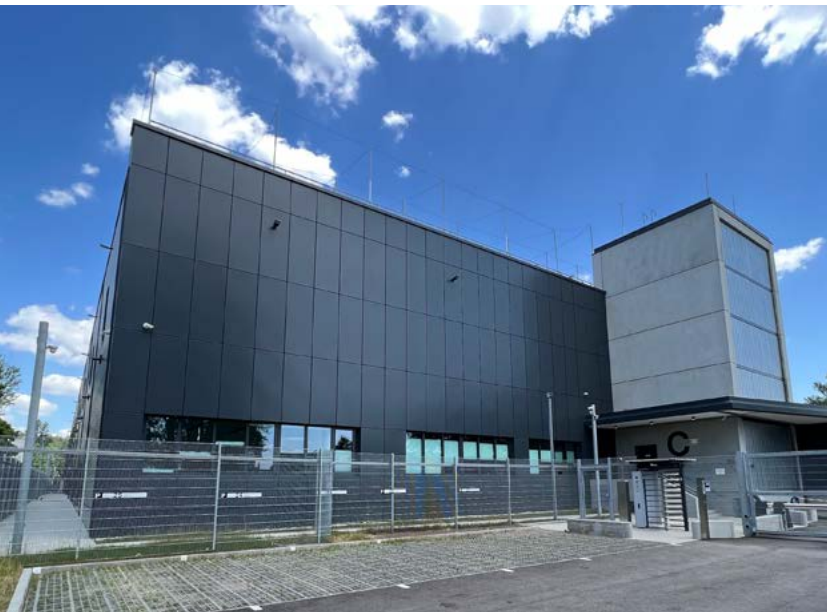
NTT Datacenter, Wien, AT
