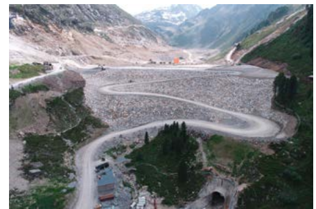
Dammschüttung SKW Kühtai, AT
