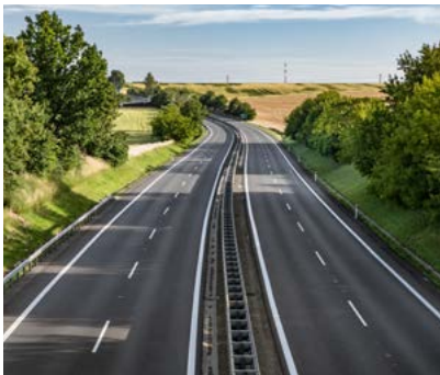
Autobahn D46, Abschnitt Vranovice, CZ
