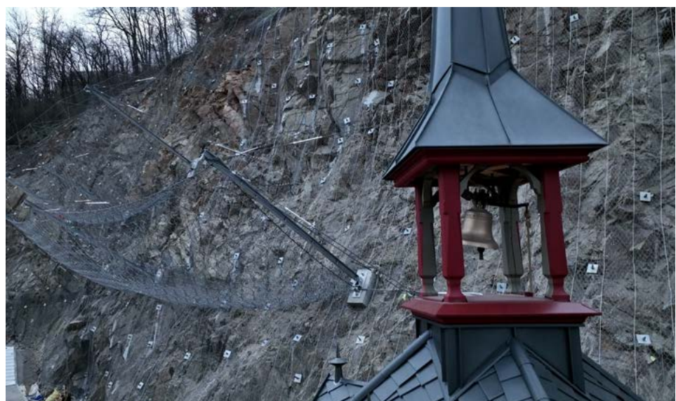
Felssicherung Brno, CZ
