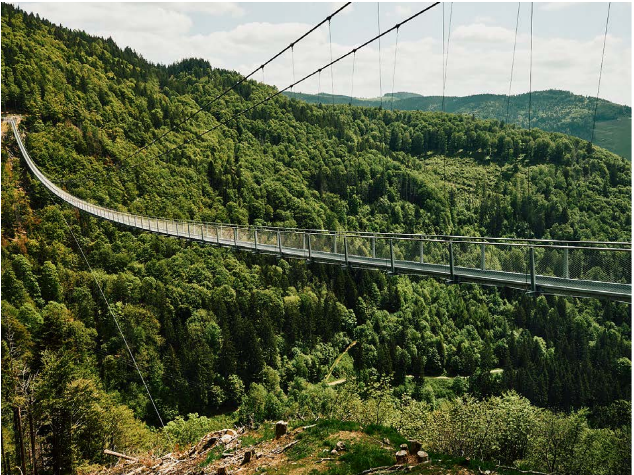
Hängebrücke Todtnau, DE
