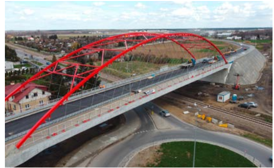
Straßen- und Bahnviadukt, Mielec, PL
