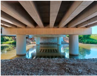
Rekonstruktion Brücke Stretava, SK
