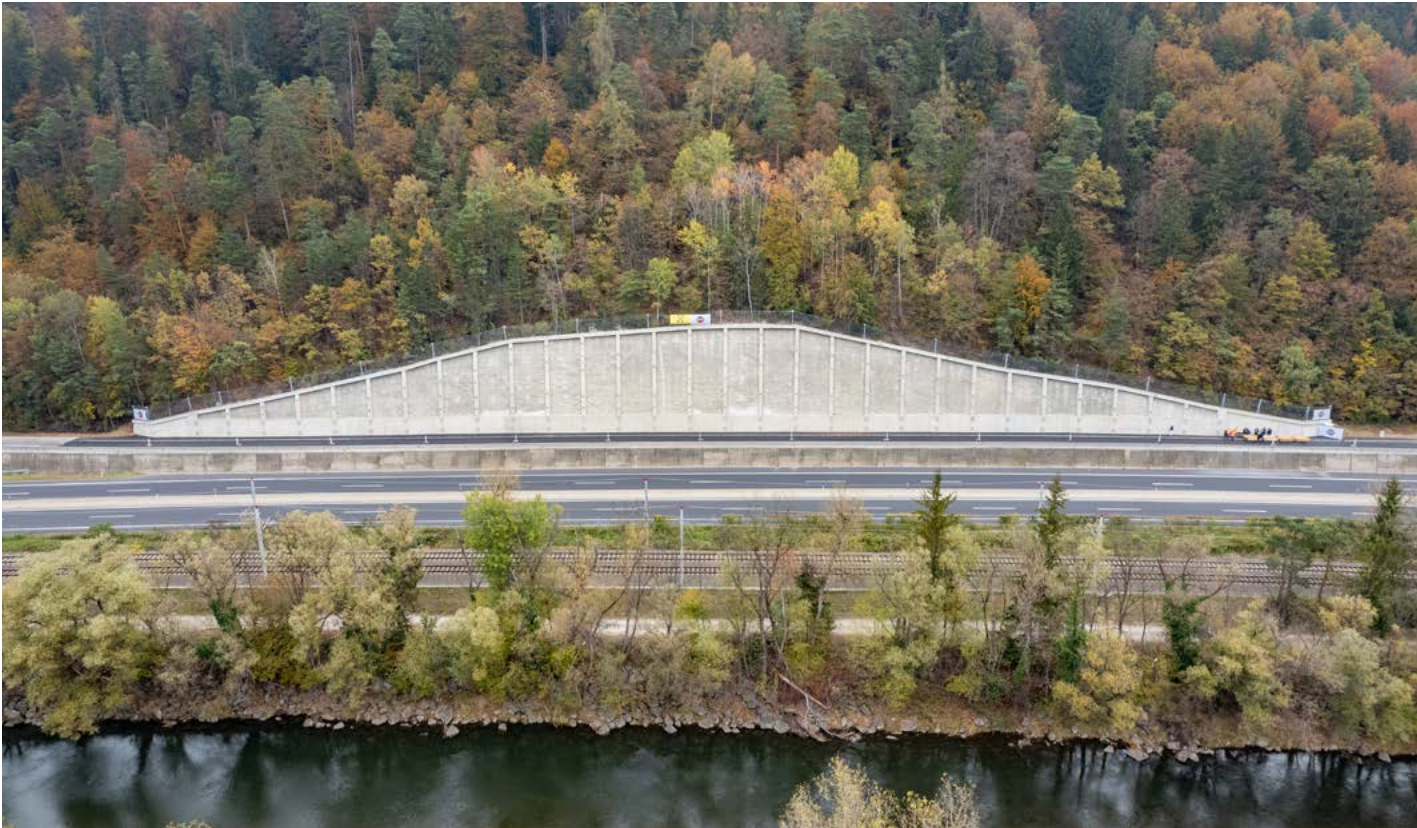
Sanierung Klagemauer, Frohnleiten, AT
