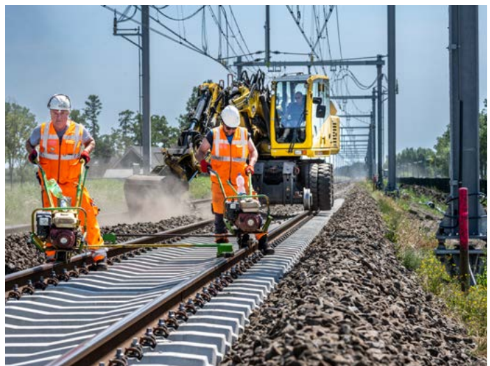
Streckensanierung Culemborg, NL
